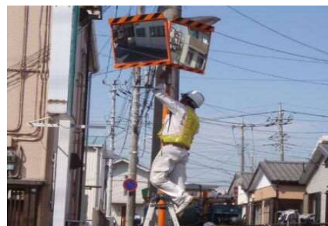
【交通安全施設修繕】
