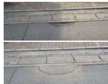
道路緊急修繕
