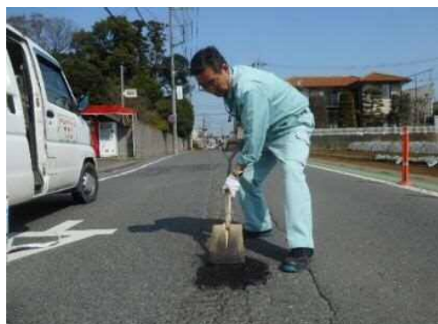
土木緊急修繕
