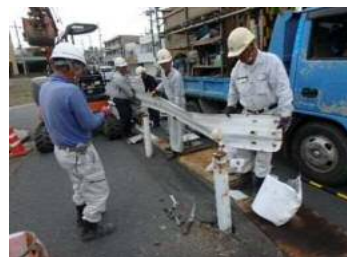
土木緊急修繕
