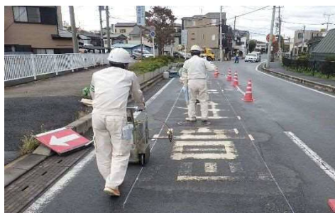
交通安全施設修繕
