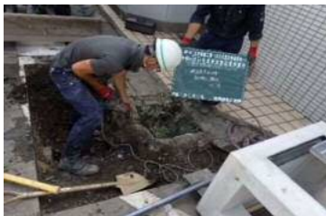
土木緊急修繕の様子
