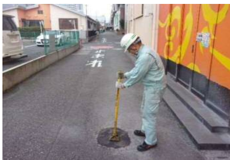
【道路緊急修繕】
