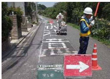
路面表示修繕
