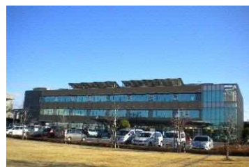
緑区役所庁舎
